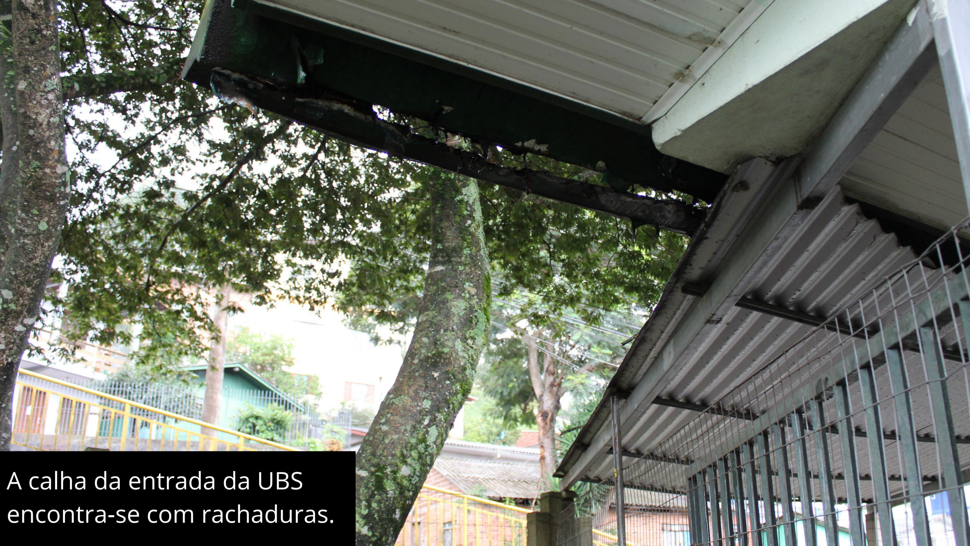
A calha da entrada da UBS encontra-se com rachaduras.
