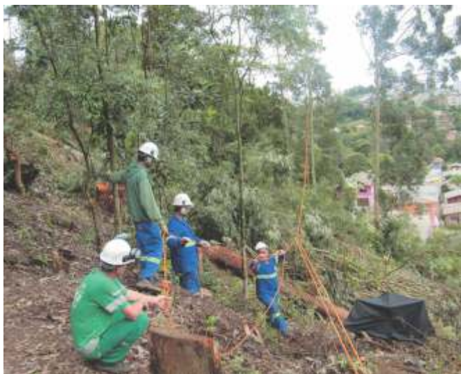
Perigo para os trabalhadores e moradores das proximidades
